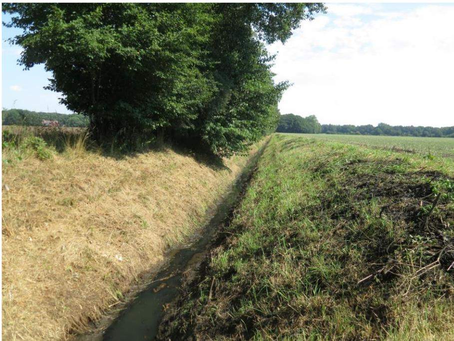
Vierte Station: Entwässerungsgraben am Brookweg zwischen Huntlosen und Huntloser Moor; über 2 Meter tief.
