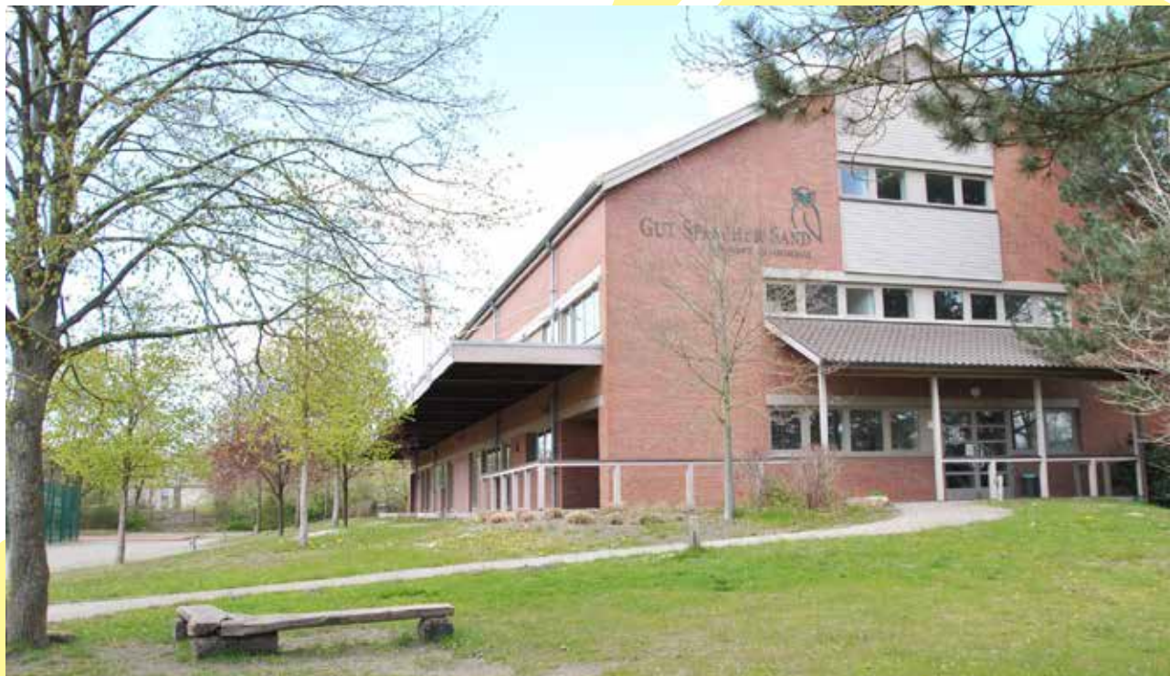
Das Schulgebäude in Spasche: neuer Standort der Förderschule und in Zukunft einer IGS?
